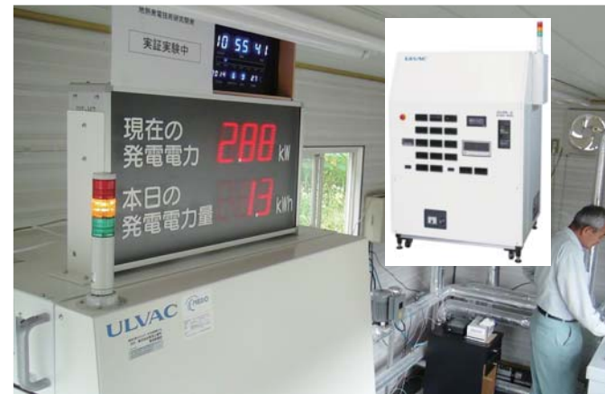
利用溫泉熱發電的小型二進制發電系統 於鳴子溫泉 2013年8月
