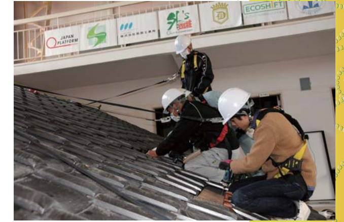
太陽能發電系統施工 基礎實習 2013年11月
